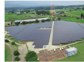
メガソーラー発電事業第1号案件のLS塩谷発電所
