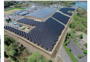
2016年に竣工したLS桜川Ⅲ発電所
