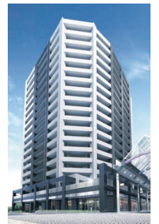
富山市「中心市街地活性化基本計画及び都市再開発法」に基づく市街地再開発事業「LUCIDA TOWER」
