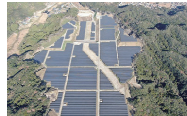
LS千葉勝浦発電所
