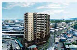
レーベン小田原 THE TOWER
