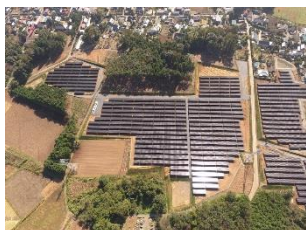
LS桜川中泉発電所 パネル出力：2.70MW FIT価格：36円/kWh
