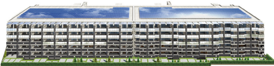
屋上に1住居あたり6枚の太陽光パネルを設置
