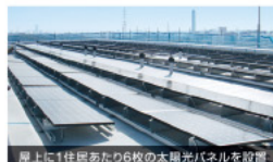
屋上に1住居あたり6枚の太陽光パネルを設置
