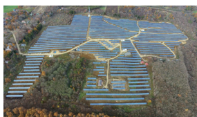
LS岩手八幡平発電所
