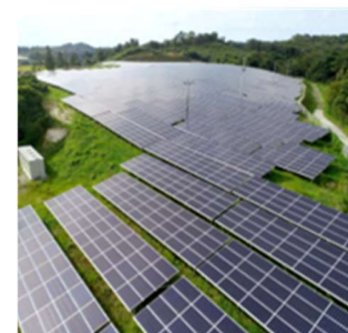
● 太陽光発電所
