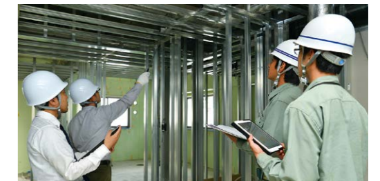
工事段階での品質管理 (イメージ)
