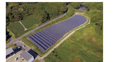
LS静岡御前崎発電所
